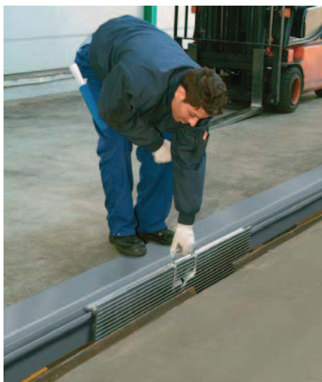
Most BB wyjąć z szyny prowadzącej.
